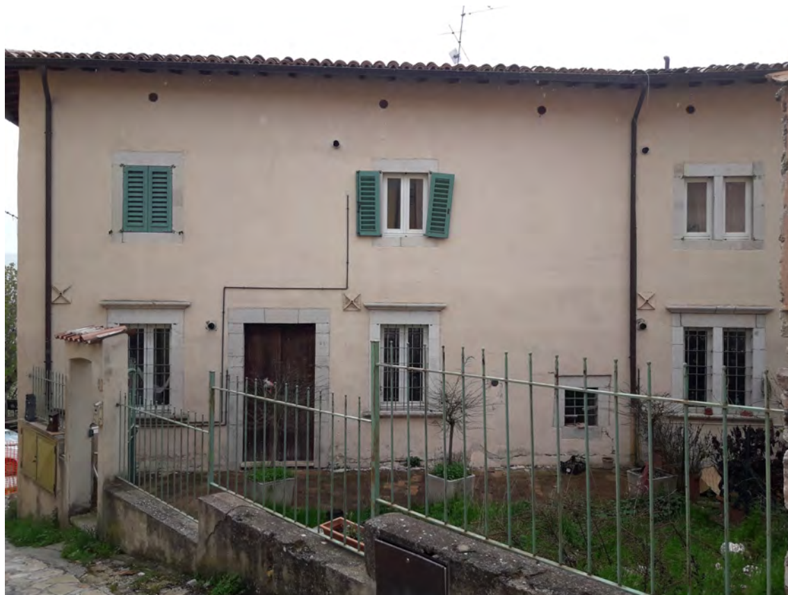
Vista posteriore dell'edificio
